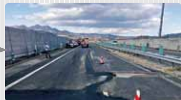
応急復旧後の様子
