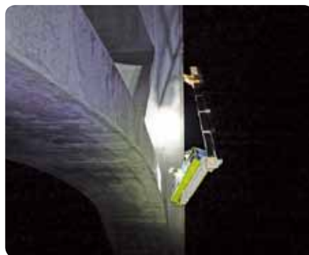
オーバーブリッジ点検(夜間)
