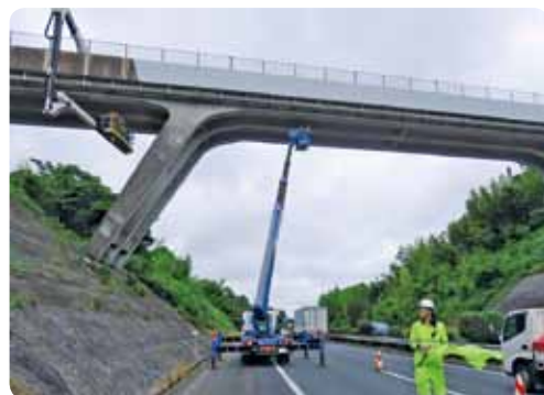
橋梁点検作業車によるオーバーブリッジ点検
