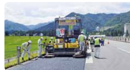
舗装補修作業
