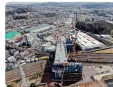
横浜環状南線(建設中)
